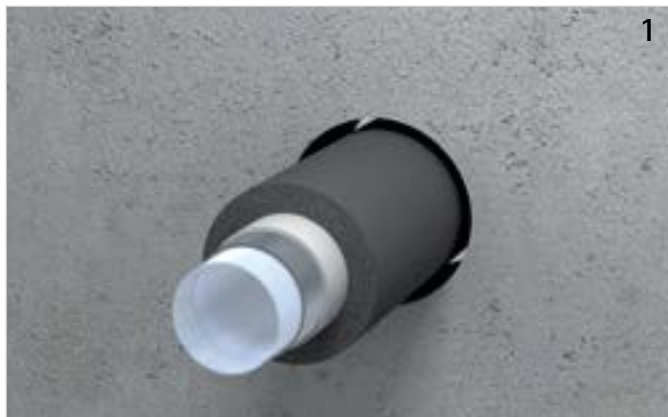
Rohrleitung (ggf. mit FEF-Isolierung) installieren.
