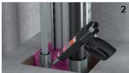
Tangit FP 550 Brandschutz-Schaum einbringen.
