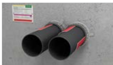
Nullabstand gedämmte Rohre
