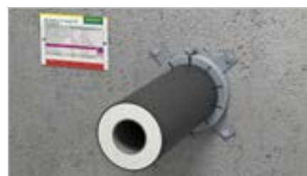
Abschottung von +GF+JRG CoolFit-Rohren bis Cool-Fit- Rohren 2.0 und 4.0
