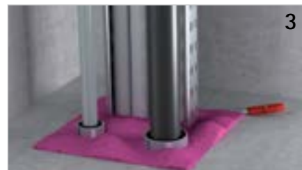
Falls gewünscht, überschüssigen Schaum abschneiden.
